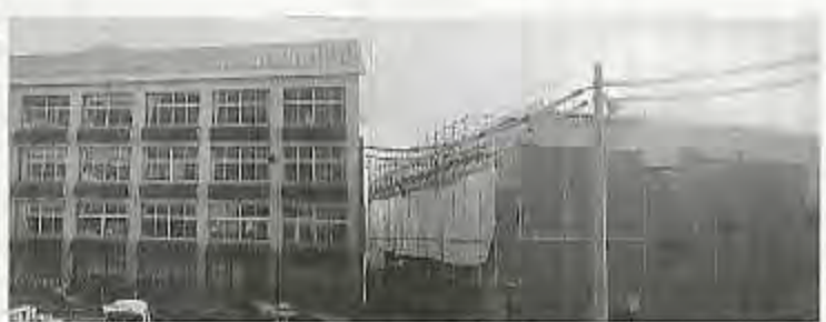
校舎と建設中の体育館
